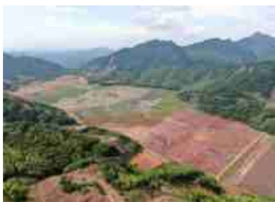
槽对坑尾矿库
