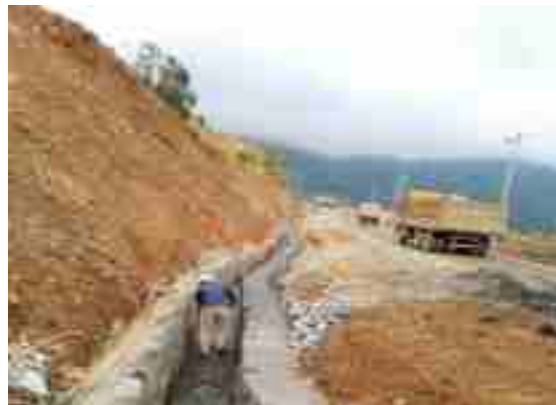
649m 平台排水沟
