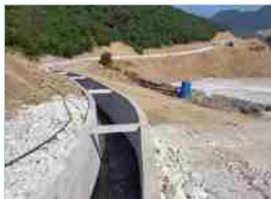
排土场截水沟
