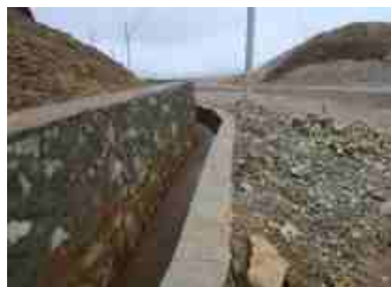
排土场道路挡墙及排水沟
