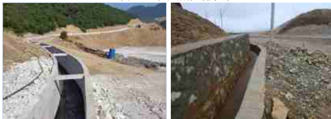
图 4-3 排土场截排水沟
