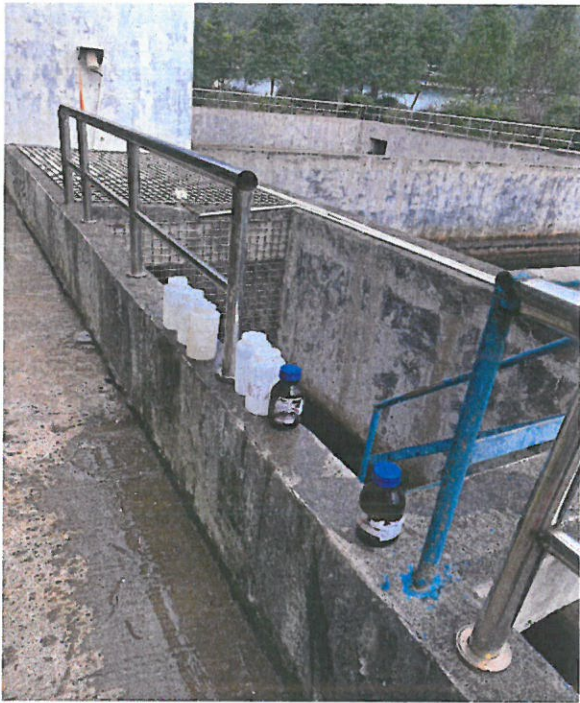
污水厂排放口（DW001）
