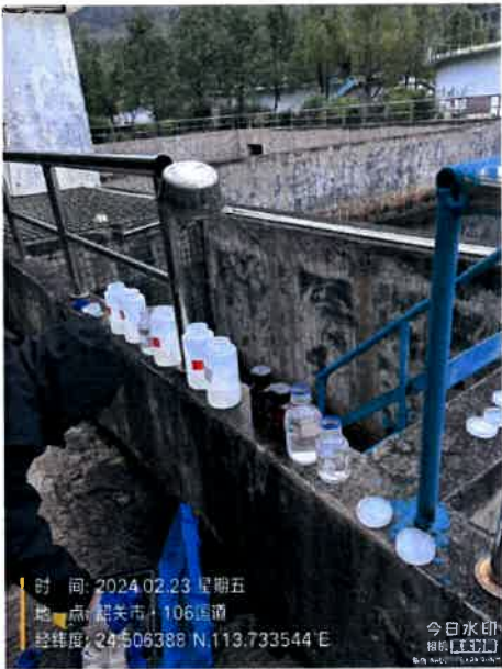
污水厂排放口（DW001）
