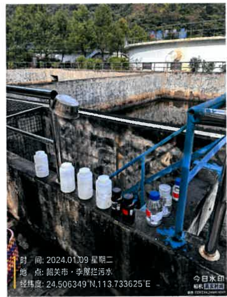
污水厂排放口 (DW001)
