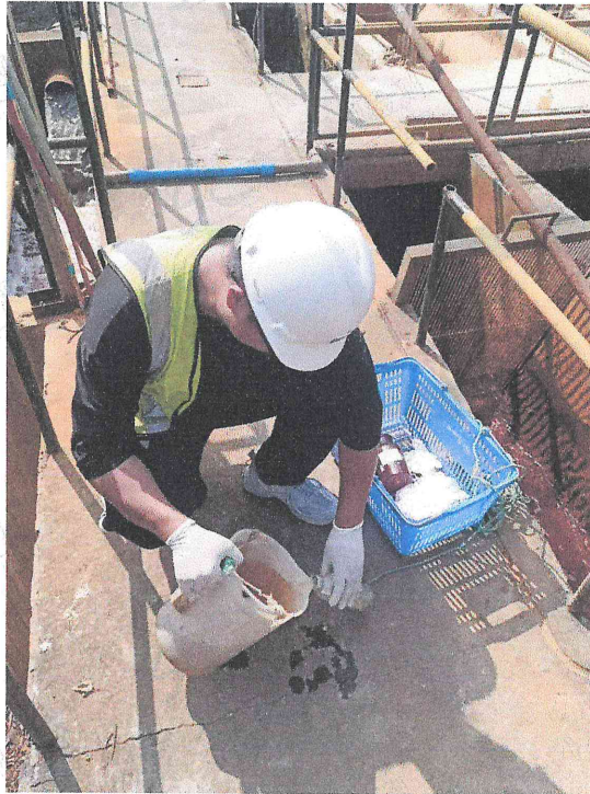
李屋拦泥库一期处理前废水采样
